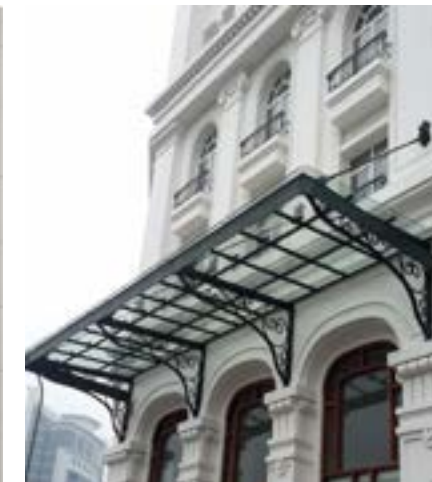
MÁI KÍNH GLASS ROOF
